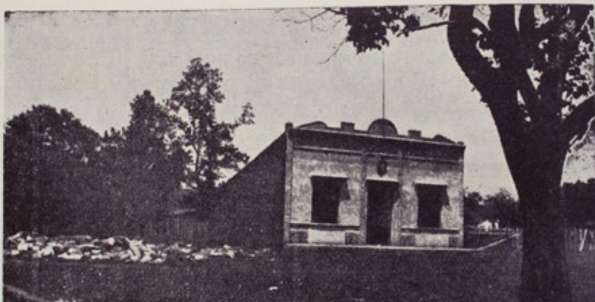
Local de la alcaldía. A la izquierda se construirá el palacio municipal
